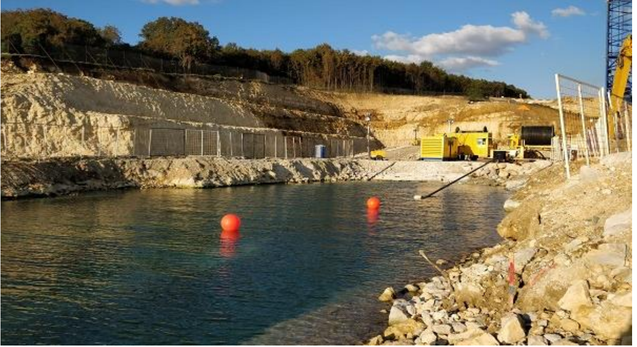
Şekil 11 – Kıyı geçişi bölümünde boru çekme operasyonu
