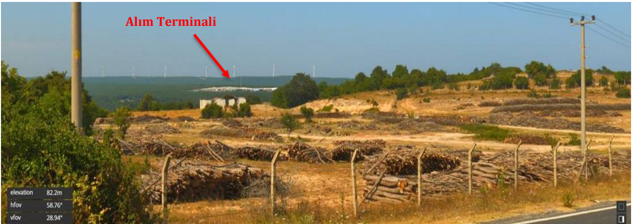
Şekil 22 – Alım Terminali'nin Kıyıköy-Vize yolundan görünümü
