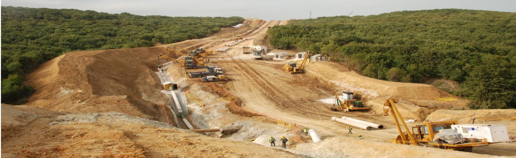
Şekil 7 – Karada boru döşeme süreci (Temsili ve Fiili)
