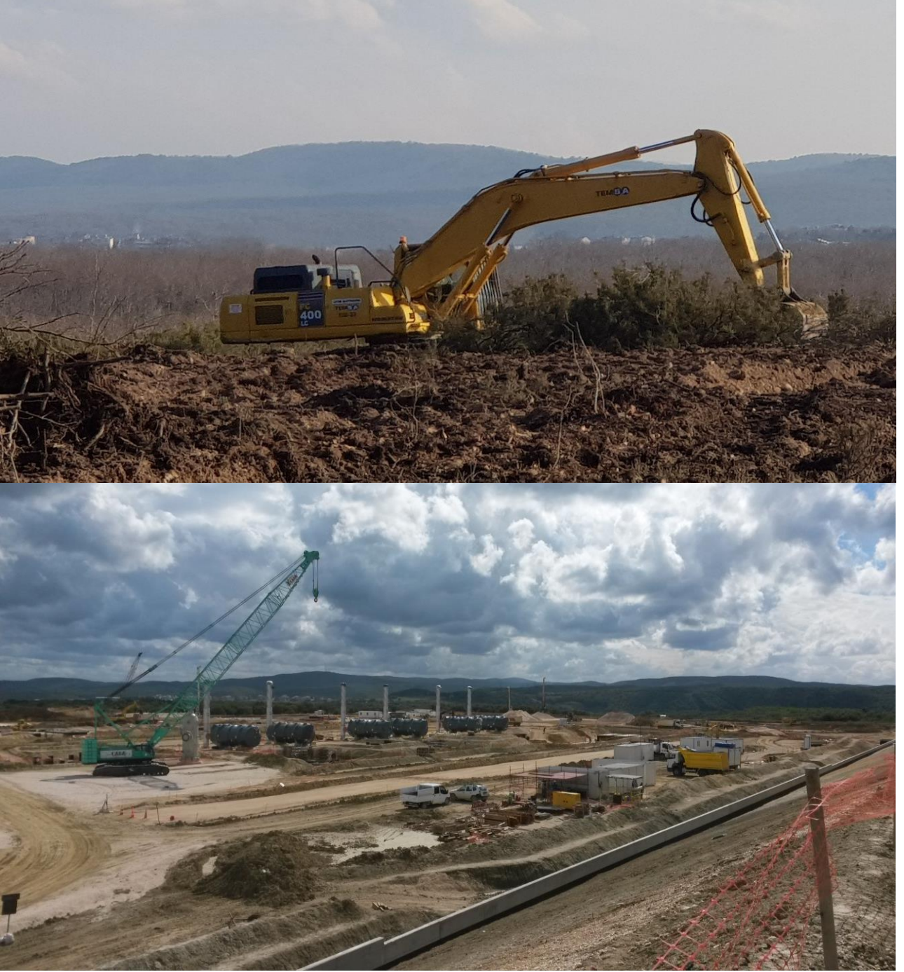
Şekil 5 – Arazi hazırlama ve Alım Terminali inşaatı
