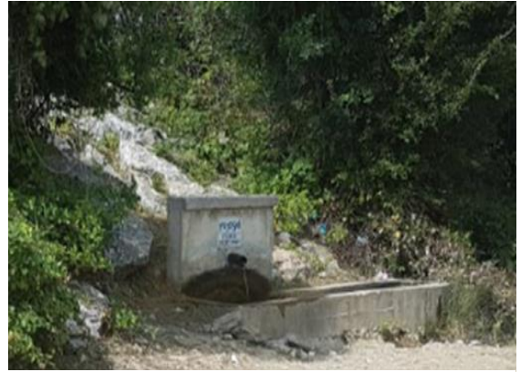
Şekil 17 – Bölgede izlenen yerel su kaynaklarından biri
