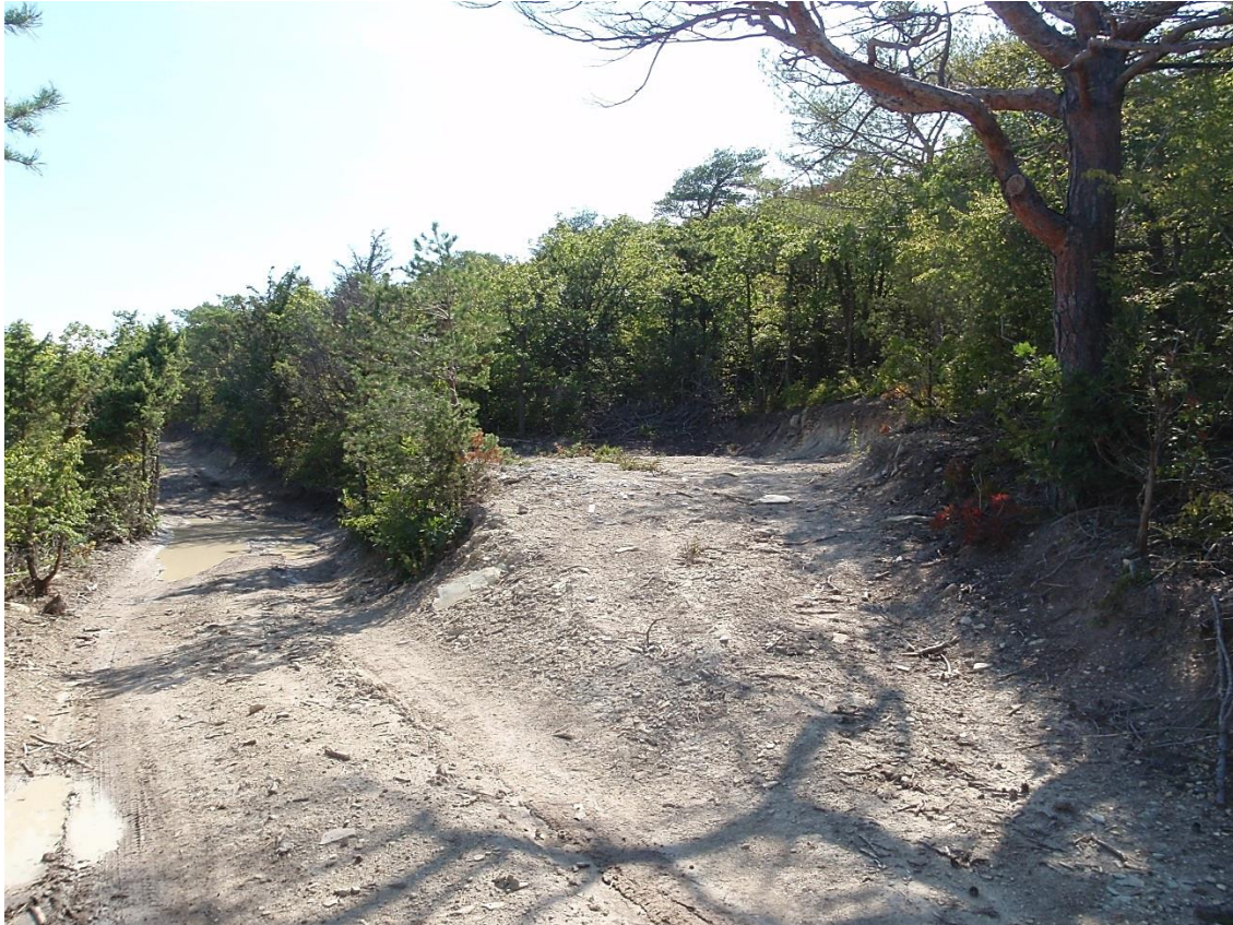
Фото 5 Буровая площадка 4, расположенная рядом с постоянной подъездной дорогой
