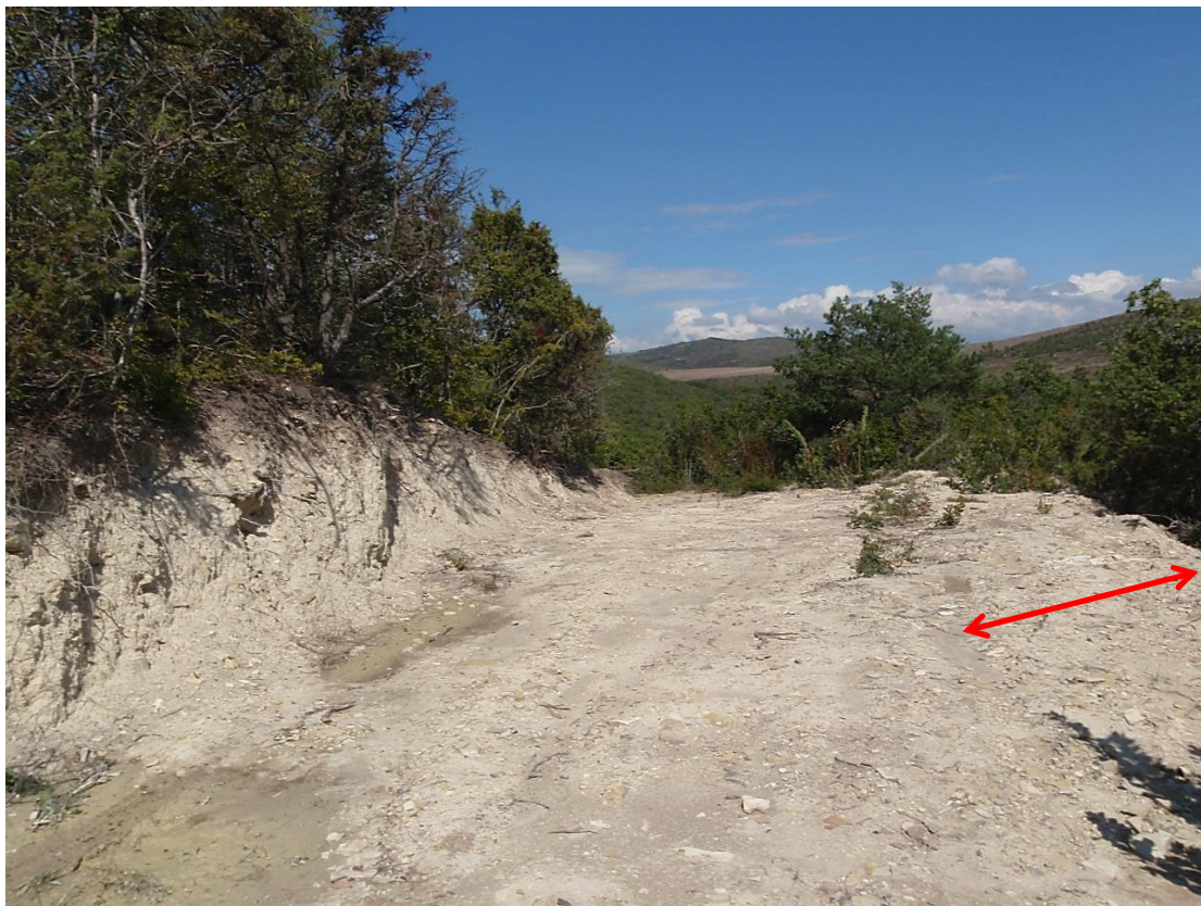
Фото 4 Подъездная дорога к буровой площадке 1 (красной стрелкой обозначен участок, нуждающийся в рекультивации)
