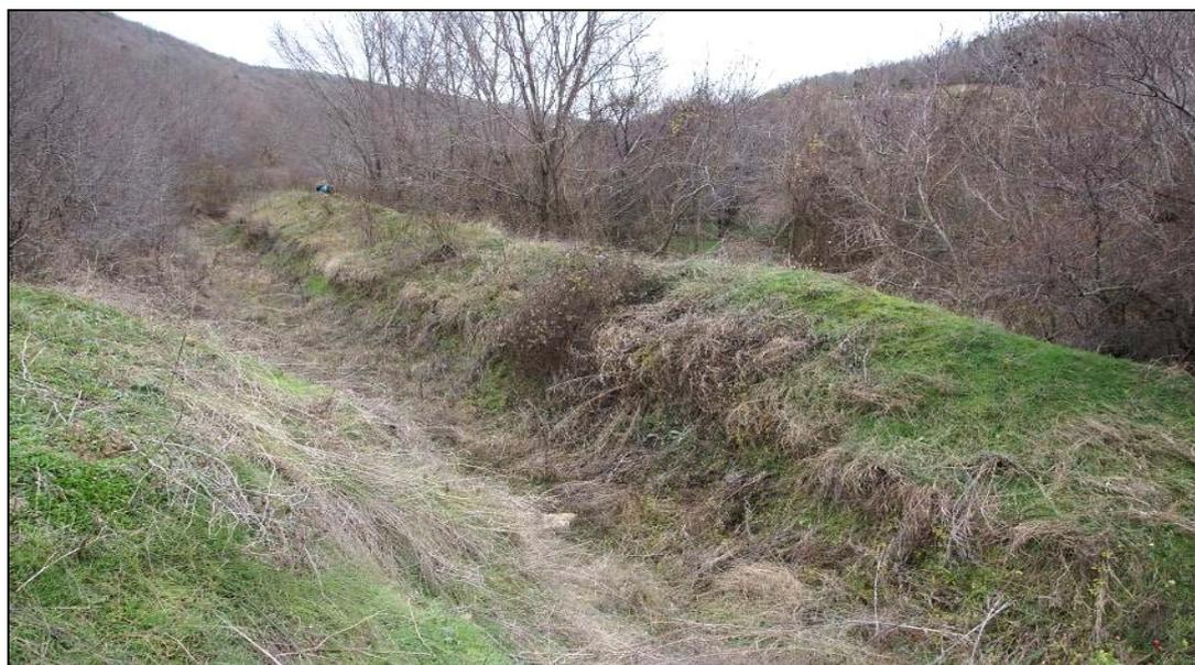
**Рисунок 4.1-4 Искусственный водоотводный канал глубиной до 2,0-3,0 м вдоль левого берега основного русла р. Шингарь**
