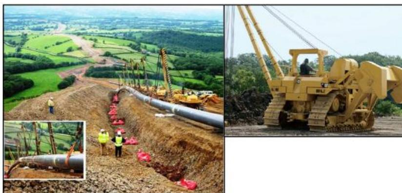
**Рисунок 1.4-4 Типичная трубоукладочная установка**
